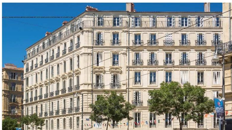
Résidence Victoria Palazzo à Marseille
