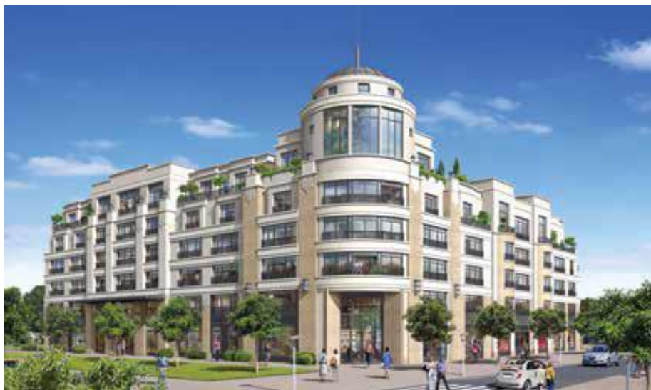
Résidence services pour séniors à Val d'Europe en cours de commercialisation
